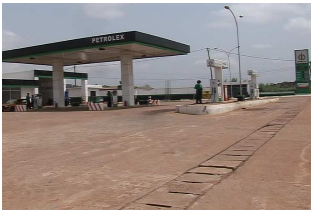
Photo de l'une des stations services du projet PETROLEX SA, basé au Cameroun et approuvé par le Fonds
